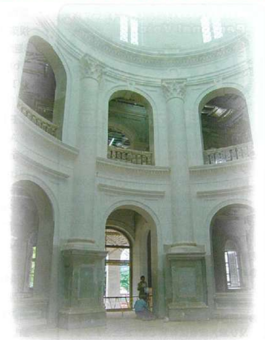
改修された旧館ドーム
