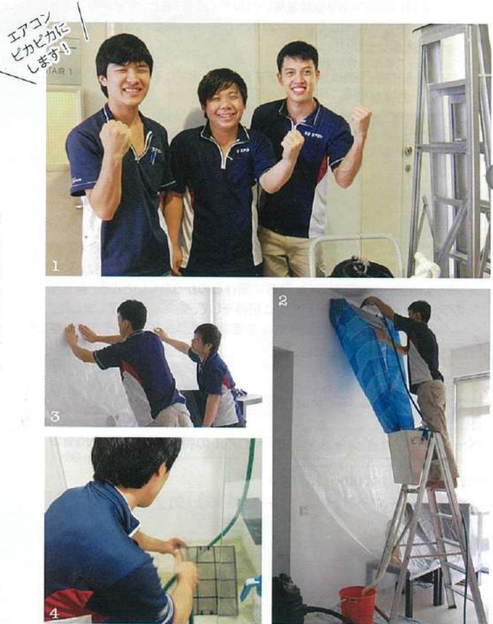
1. 2~3人1組のチームで訪問。当地で16年の実績があり、日本大使館なども契約する信頼のサービスを提供。2. 作業の前に、ビニールシートで室内を保護。3. 分担作業でスピーディー。4. ビニールシートで水の通り道を作り、専用洗剤でしっかりと汚れを洗い流すケミカルウォッシュ。
